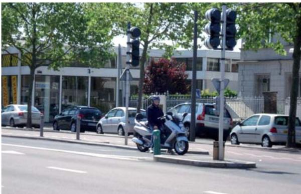
Pour limiter les risques de collision du véhicule tournant à gauche avec celui en mouvement direct dans le sens opposé : les masques ponctuels générés par le panneau sur l'îlot en dur ou le masque végétal sur le terre-plein central doivent être déplacés ou supprimés.
