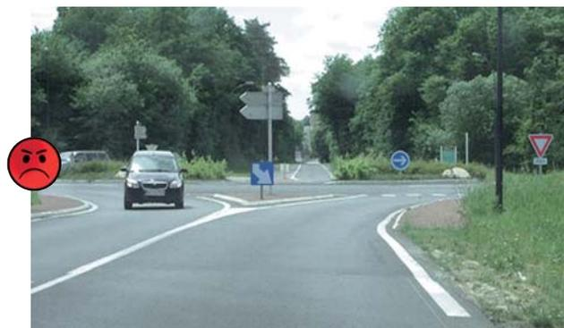
Carrefour giratoire présentant une mauvaise visibilité (perspective linéaire) : les vitesses risquent d'être inadaptées.
