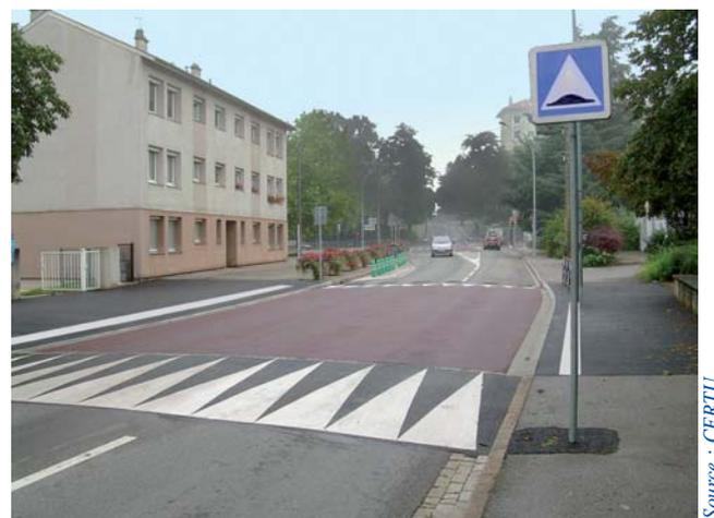
Le plateau en carrefour permet d'assurer un ralentissement des véhicules, de rendre plus visible l'intersection et d'améliorer l'aisance de la circulation piétonne lors de la traversée. Il peut être utilisé dans tous les types de carrefour.
